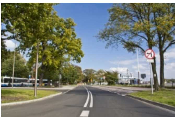
Przebudowa ulicy Wybrzeże Władysława IV
