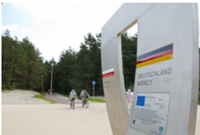
Transgraniczna promenada pomiędzy Świnoujściem i Gminą Heringsdorf - budowa przejścia na granicy Państwowej
