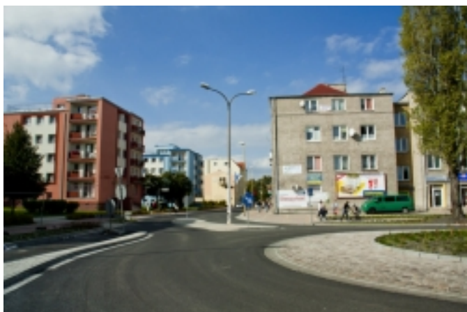
Przebudowa centralnego układu komunikacyjnego śródmieścia w Świnoujściu
